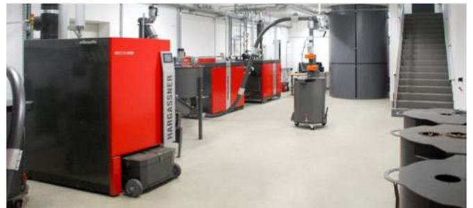
Diese KWK-Anlage wird mit dem selben Brennstoff wie die Hackgutanlage – mit getrocknetem Wald-Hackgut – beheizt. Sie dient nun als Sommerkessel bzw. im Winter als Grundlastkessel für die Wärmeversorgung. Die erzeugte elektrische Energie wird als Ökostrom ins öffentliche Netz eingespeist. Dadurch wird jetzt nicht nur das Ortszentrum mit biogener umweltfreundlicher Wärme versorgt, sondern auch ein Teil der Stromversorgung übernommen.
