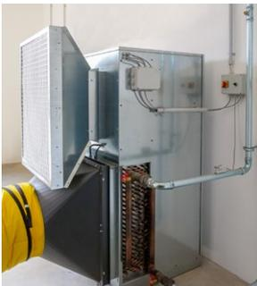
Das Hargassner Warmluftmodul WLM kann auch als Stand-Alone Lösung für Heizanlagen in ortsfesten Heizräumen verwendet werden. Das Modul vereint den Wärmetauscher und das Gebläse mit Ansaug- und Abluftvorrichtung in einer kompakten Einheit für Leistungsgrößen bis zu
