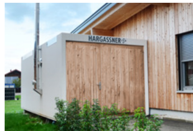
Eco-Box 20 kW Pellets, Wohnhausanlage
