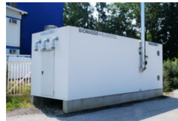
Einstock-Heizmodul 120 kW Pellets, Gewerbeobjekt
