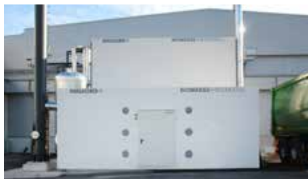
Vícenásobný topný kontejner 660 kW štěpka, průmysl
