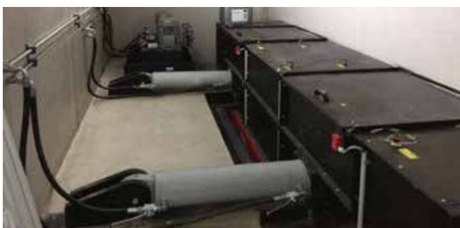
Masivní hydraulický válec pro pohyb posuvné podlahy
