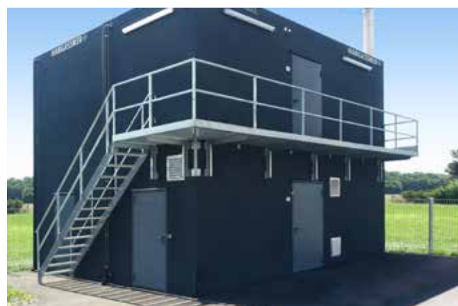
Čtyřkontejnerová varianta na štěpku u průmyslového objektu.
