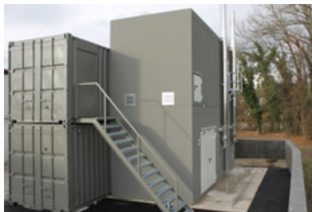
Dvoupatrový topný kontejner 2x90 kW pelet, průmysl
